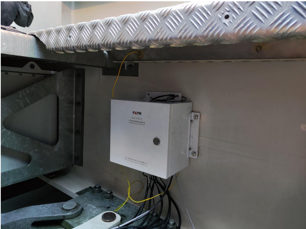
图 2 采集器安装示例图
