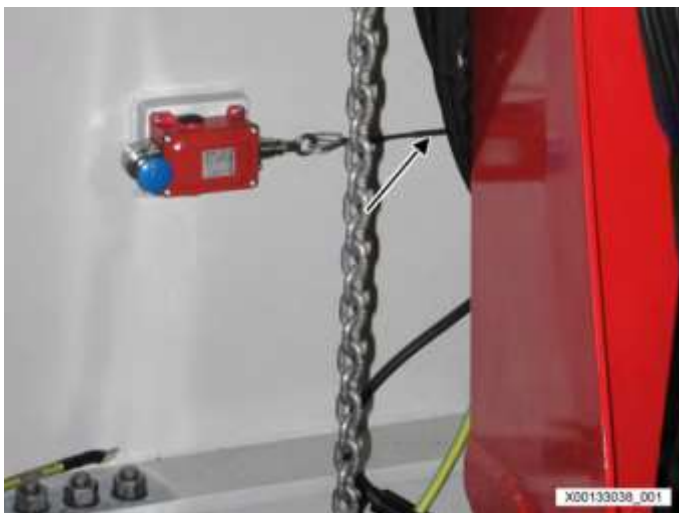
机舱右侧的紧急停止电线
