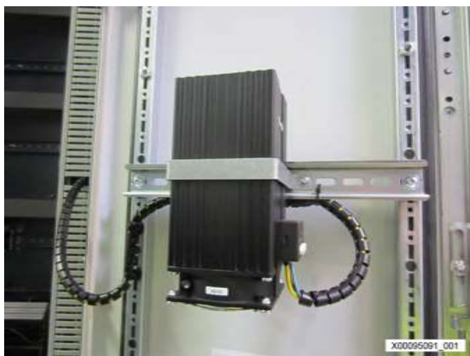
控制柜中的加热元件
