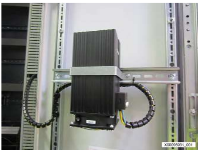
控制柜中的加热元件
