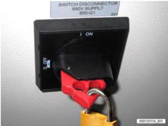
偏航电机用 690V 电源开关，已被锁定
