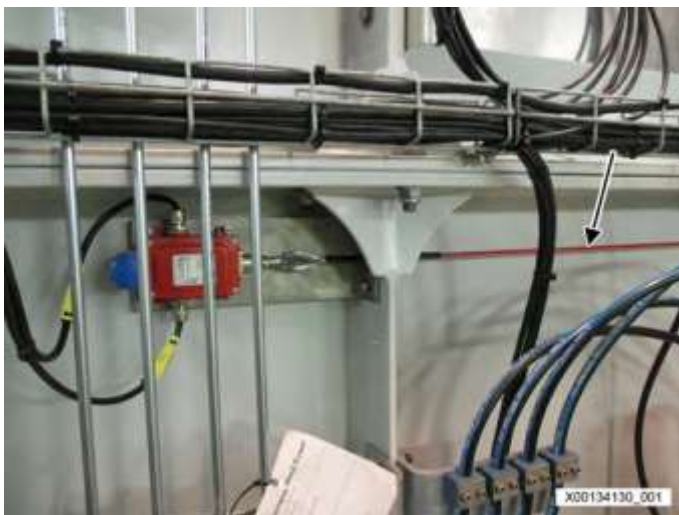
(1) 机舱中的紧急停止按钮的位置
