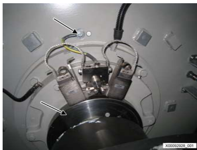
接地框架上的测量点（接触一个没有涂层的点）。
