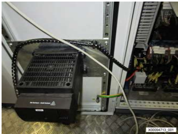
控制柜中的加热元件
