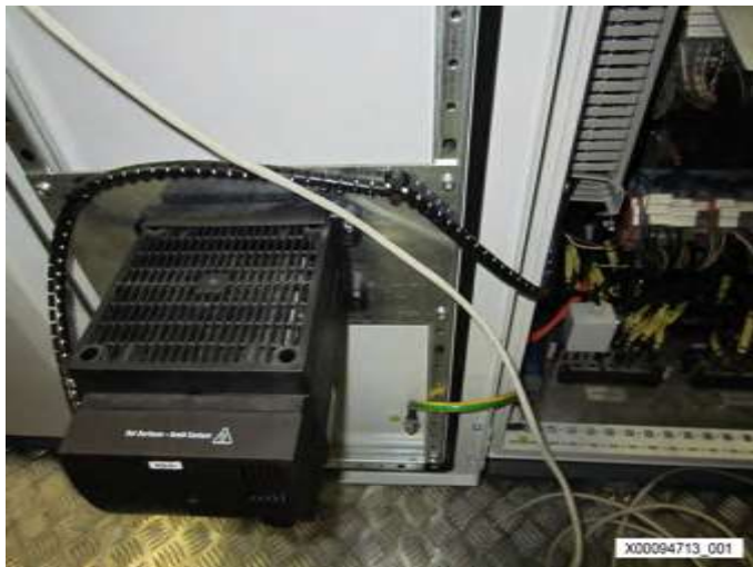
控制柜中的加热元件
