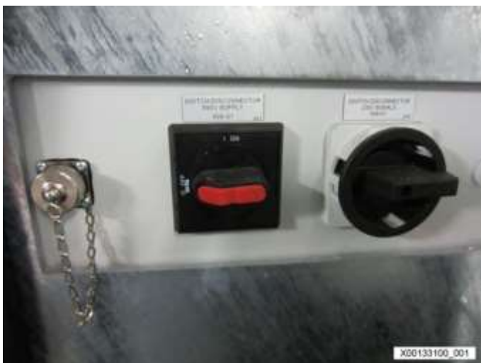
A3 柜上偏航电机用的 690V 电源开关
