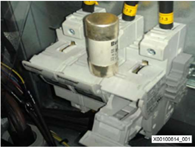
熔断器被拆除
