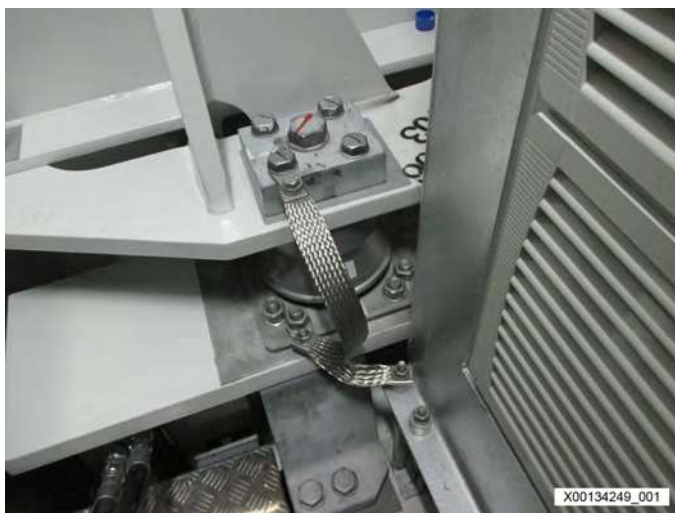
发电机的避雷装置
