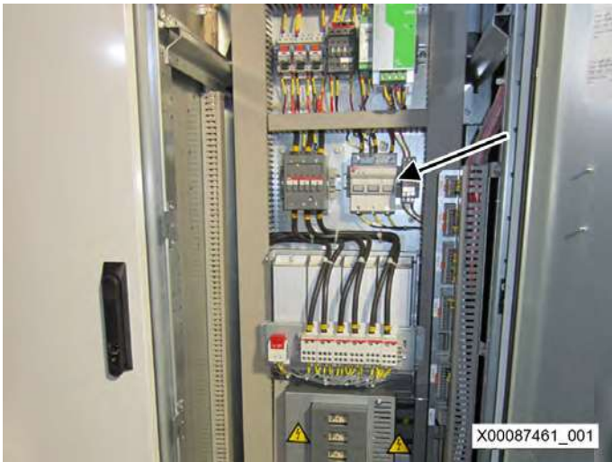
变阻器的熔断器
