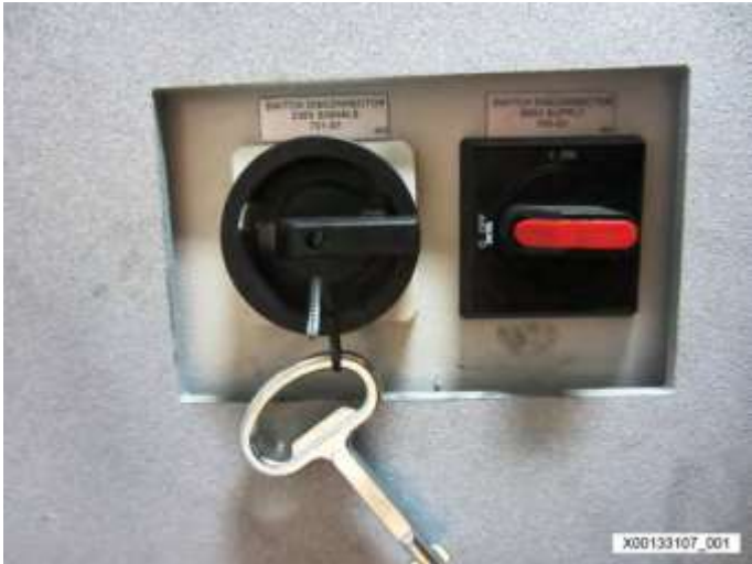
A18 柜上偏航电机用的 690V 电源开关
