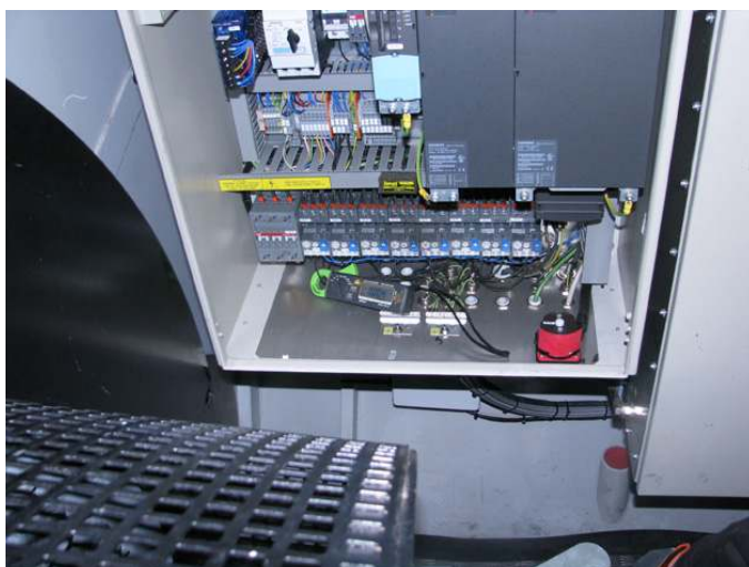
测量 A18 中偏航电机的耗电量
