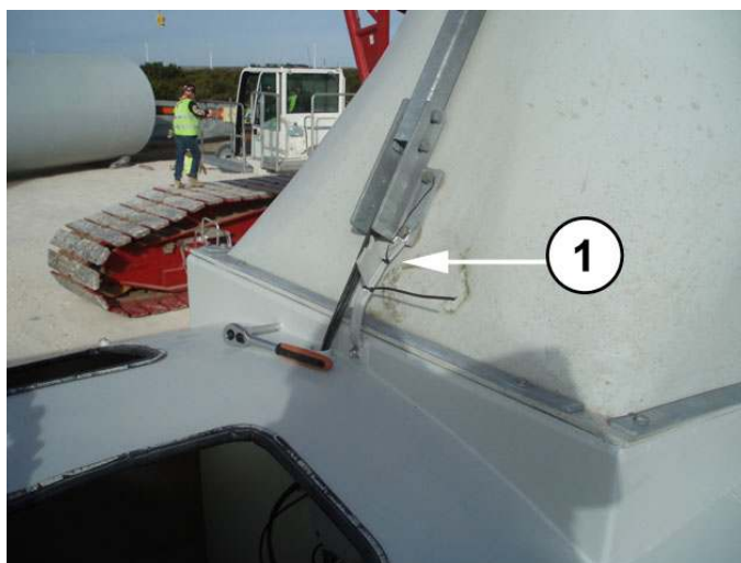
(1) 接地电缆上的避雷卡
